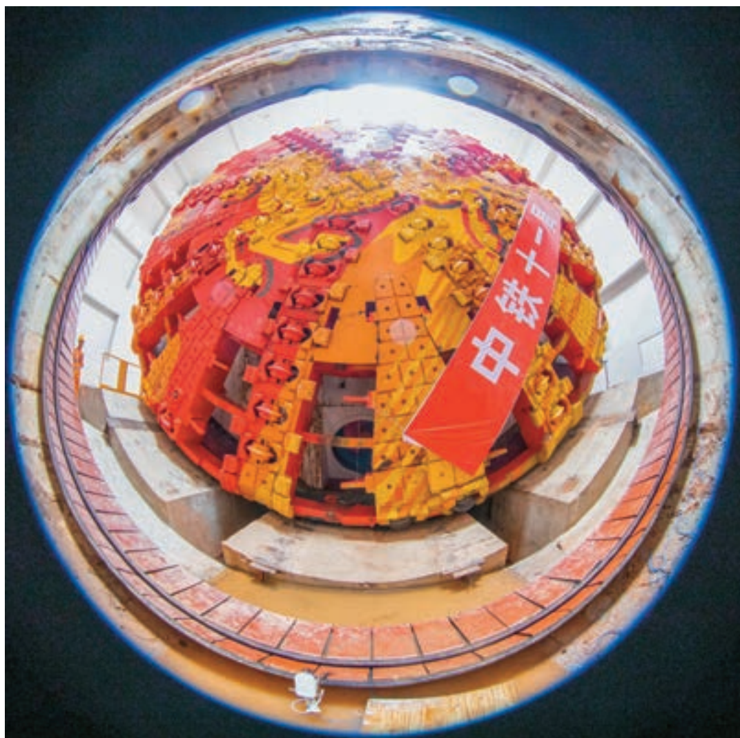
2026年7月31日，在位于河南省洛阳市的焦济洛平高铁邙山隧道施工现场，随着“焦平一号”超大直径盾构机刀盘缓缓转动，标志着该隧道施工正式进入盾构掘进阶段。
